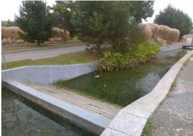
Figure 14. Photographie d'une mesure compensatoire (création de noue) dans le secteur du projet de la ZAC Atalante
